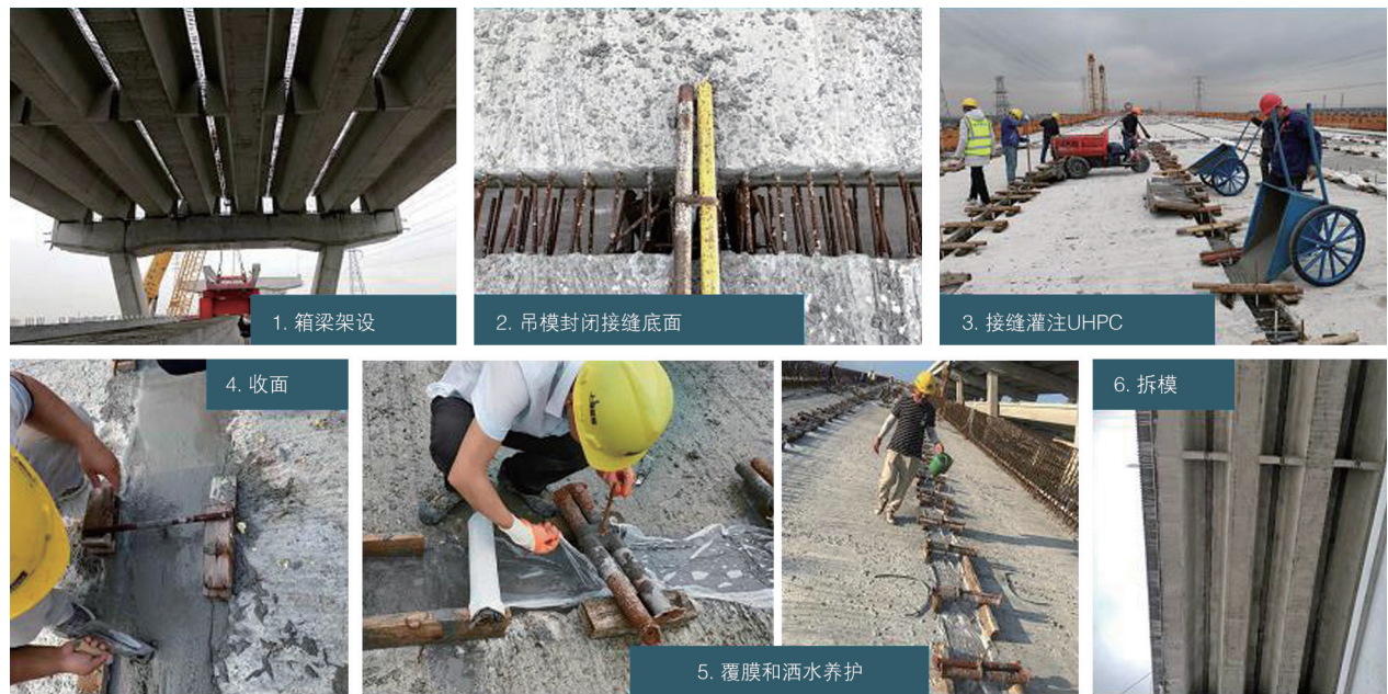
图4 箱梁纵向UHPC湿接缝施工(上海复培提供照片)
