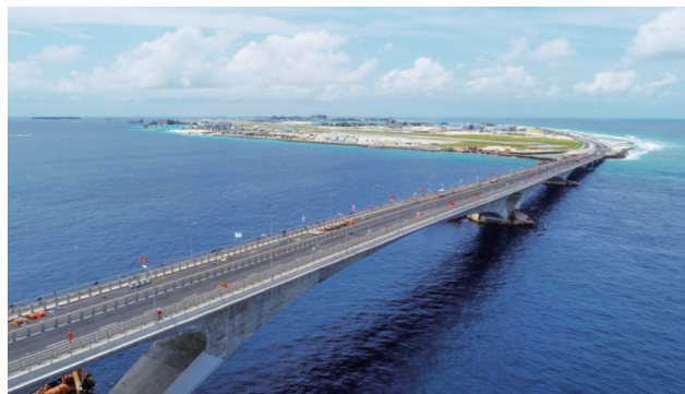
图2 援马尔代夫——中马友谊大桥钢桥面UHPC铺装与建成后(中交二航提供照片)
